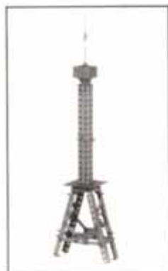
Sendeturm A large broadcast tower Télécommunications Zendertoren
